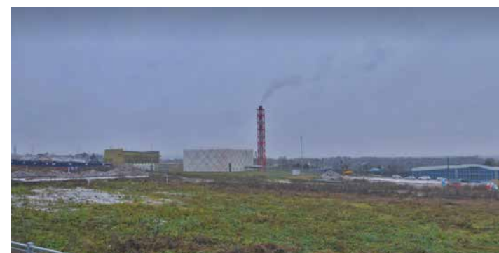
Котельная в составе ЖК «Новые Ватутинки, Микрорайон «Заречный»
