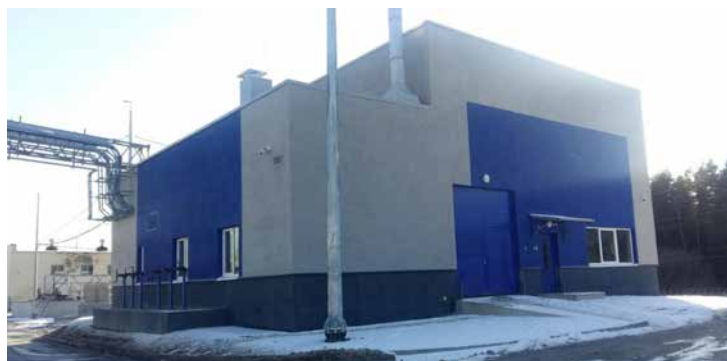
Реконструкция локальных очистных сооружений (ул. Промышленная, д.3)
