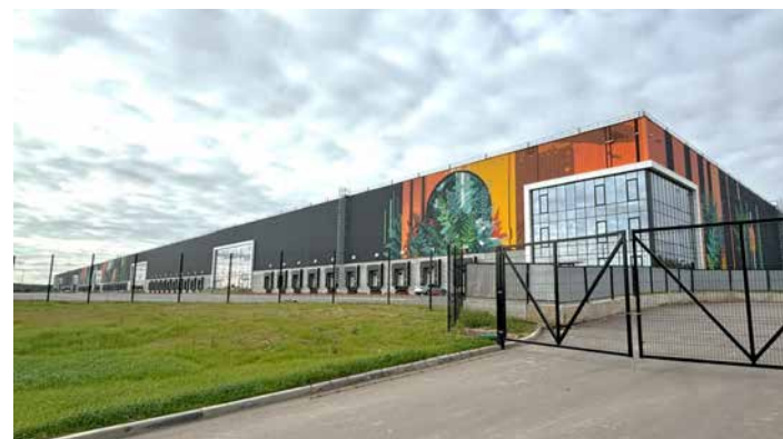
Складское здание, корпус №1 в составе Логистического комплекса Промышленно-логистического парка (вблизи д. Кувекино). Застройщик АО «СЗ «ЭлитГрад»
