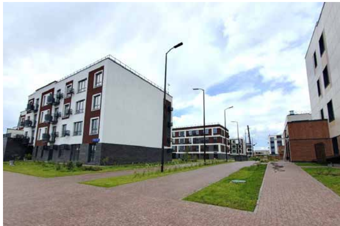
ЖК «Яковлево» (застройщик – ООО «КИТ МонАрх»)
